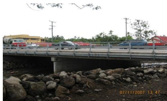
New Bridge: Vaimoso
